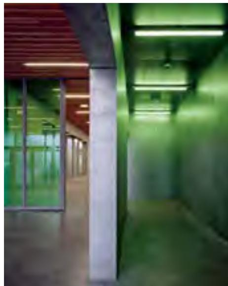
La laine de roche absorbant le bruit est cachée par une tôle d'acier perforé sur les parois et le plafond du sas acoustique, et par un lattis de bois au plafond de la salle polyvalente
